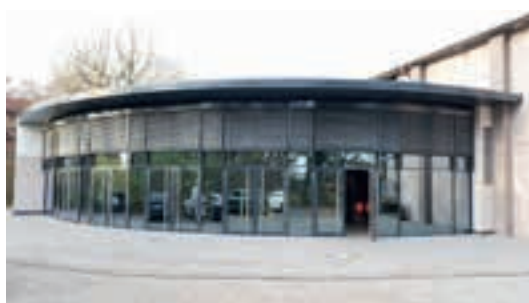
Neue Foyer-Erweiterung. Foto: Christian Bucker
