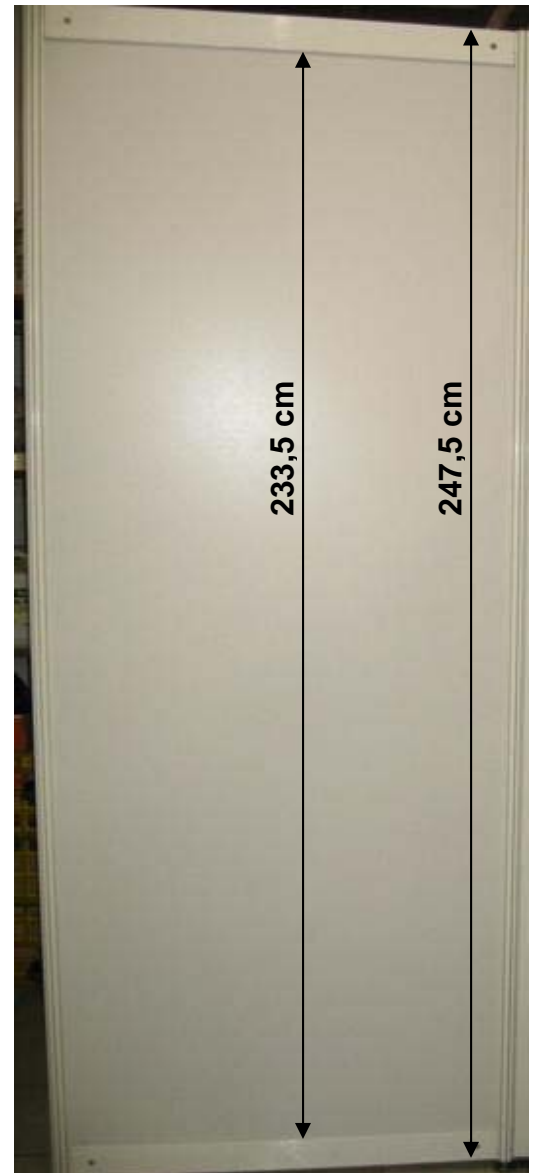
Vom Boden sind die Wände ca. 2,50 m hoch. Jede Wand ist ca. 1 m breit (inkl. der Verbindungsschienen).
